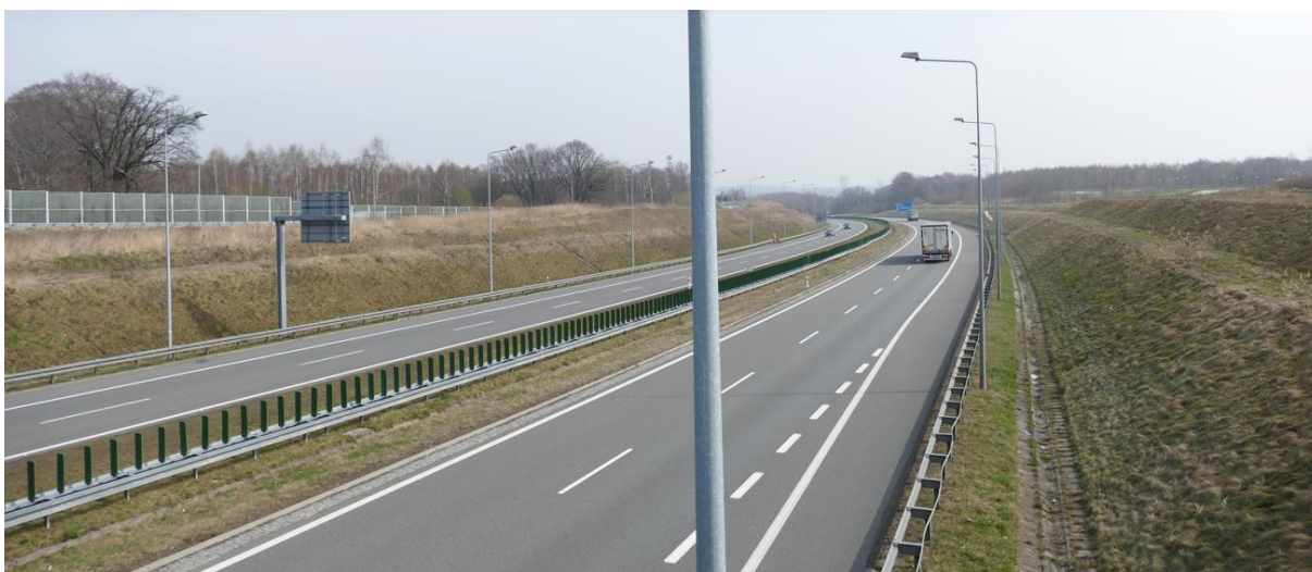
Fot. 17. Przebieg autostrady A1 w południowej części gminy
