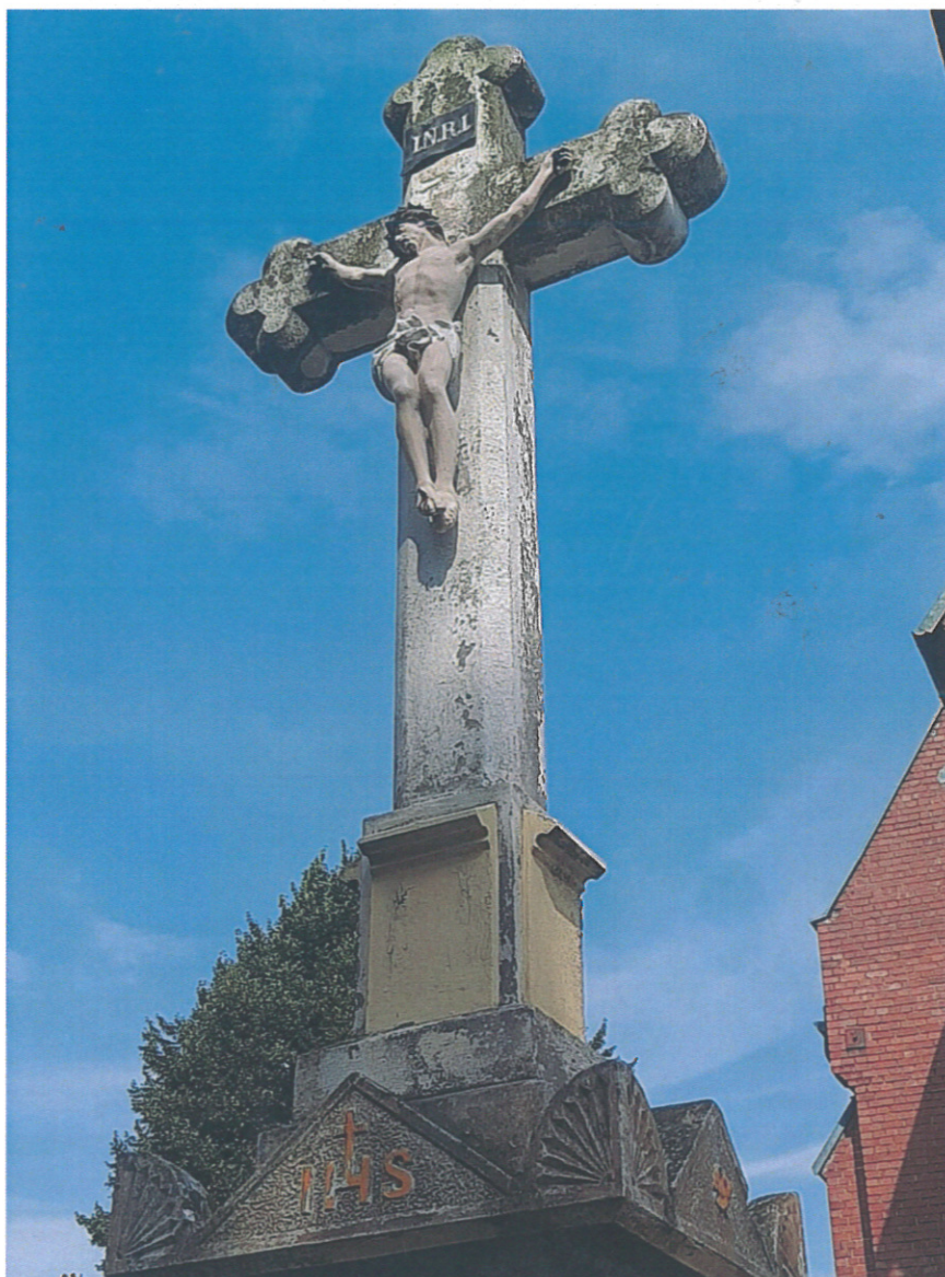
Fot. 4. Mszana, Kamienna kapliczka słupowa, widok krzyża wraz z rzeźbą Chrystusa Ukrzyżowanego wieńczące obiekt. Stan przed konserwacją, sierpień 2020 r.
