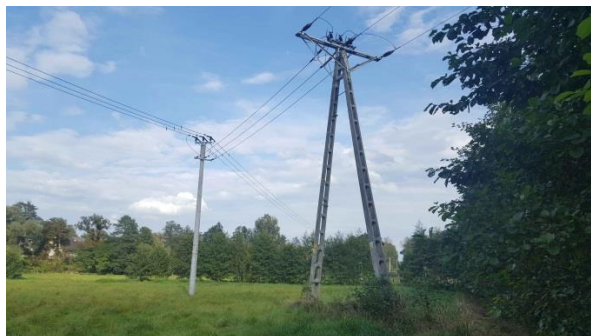
Fot. 3. Widok na słupy elektroenergetyczne w centralnej części opracowania.
