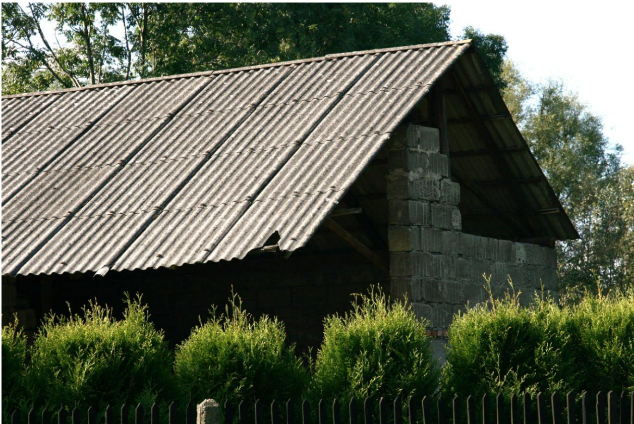
Rysunek 3 Dach budynku gospodarczego pokryty płytami azbestowymi falistymi (I stopień pilności)
