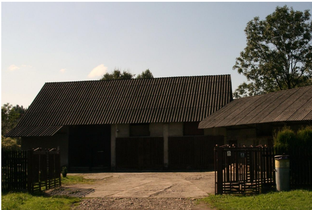
Rysunek 4 Dachy budynków gospodarczych pokryte płytami azbestowymi falistymi (II stopień pilności)
